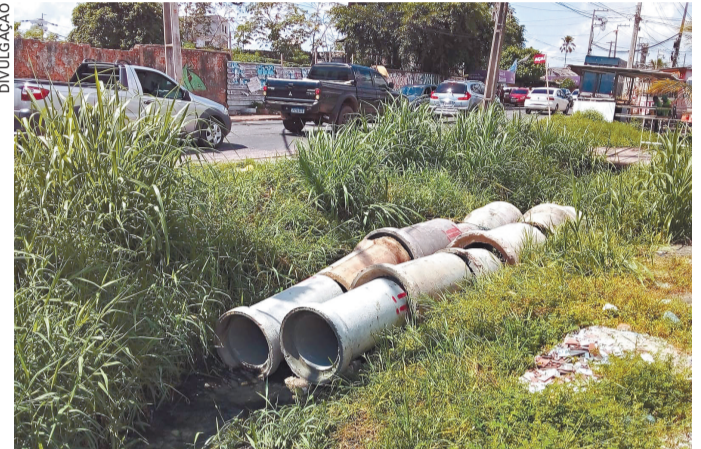
Tubos de concreto foram descartados irregularmente em canal
