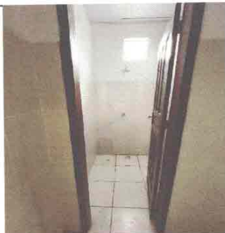
BANHEIRO FUNCIONÁRIOS MASCULINO
