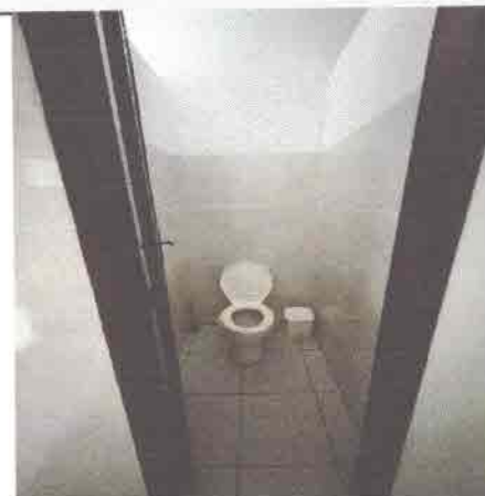
BANHEIRO FUNCIONÁRIOS MASCULINO
