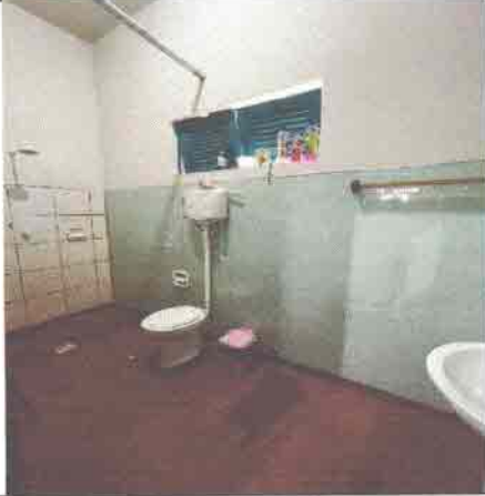
BANHEIRO QUARTO HÓSPEDES
