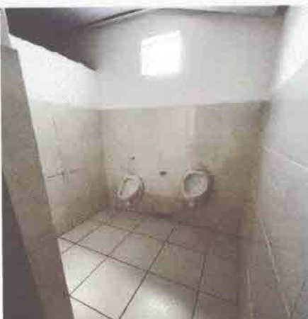
BANHEIRO FUNCIONÁRIOS MASCULINO
