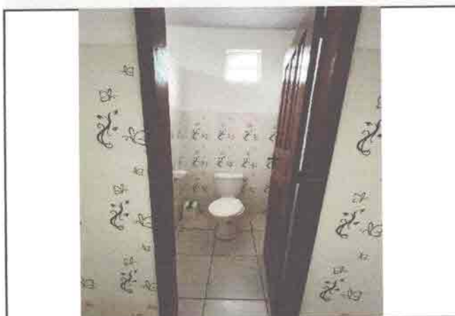
BANHEIRO FUNCIONÁRIOS FEMININO
